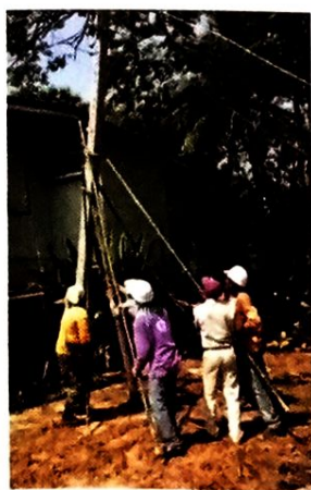
รูปที่ 3.3 การปักเสาโดยใช้แรงงานคน
