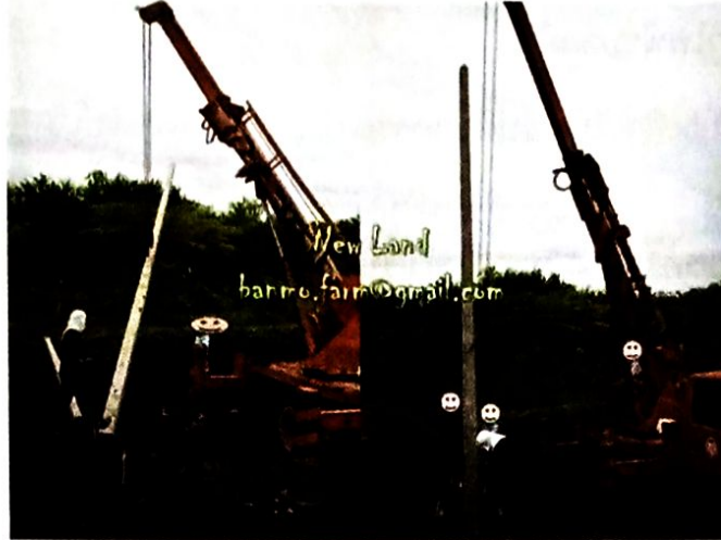
รูปที่ 3.4 การใช้รถปักเสาไฟฟ้า
