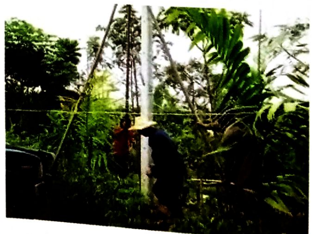
รูปที่ 3.3 การปักเสาโดยใช้แรงงานคน
